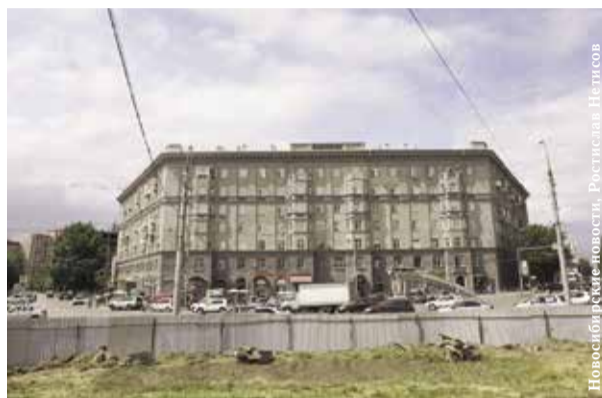
НА ФОТО: РАБОТЫ ПО УСТАНОВКЕ СТЕЛЫ ВЕДУТСЯ НА ПЛОЩАДИ КАЛИНИНА
