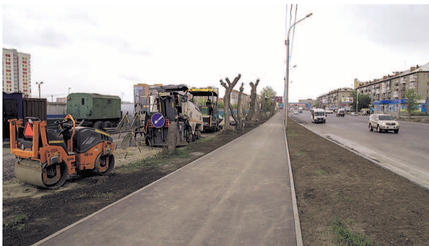
НА ФОТО: НА УЛИЦЕ УКЛАДЫВАЮТ НОВЫЙ АСФАЛЬТ
