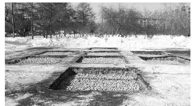
НА ФОТО: В НАРЫМСКОМ СКВЕРЕ УЖЕ ЗАКЛАДЫВАЕТСЯ ФУНДАМЕНТ
