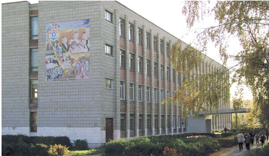
НА ФОТО: ШКОЛЕ №14 ТРЕБУЕТСЯ РЕМОНТ
