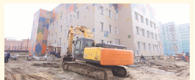
НА ФОТО: РАБОТЫ ИДУТ ПОЛНЫМ ХОДОМ
