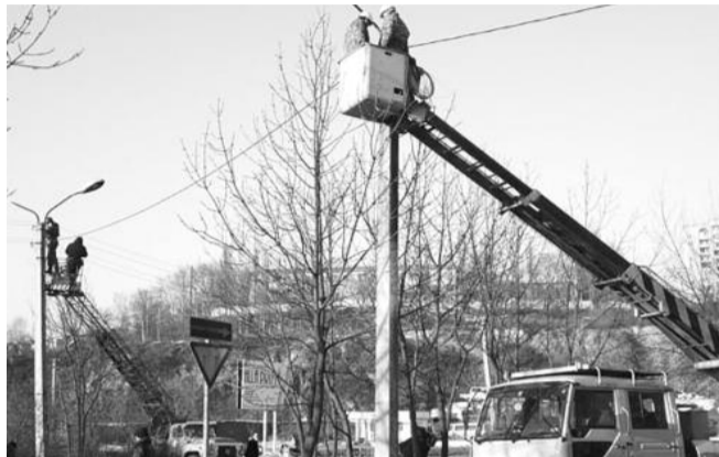
■ НА ФОТО: ИДЕТ РЕМОНТ УЛИЧНОГО ОСВЕЩЕНИЯ
