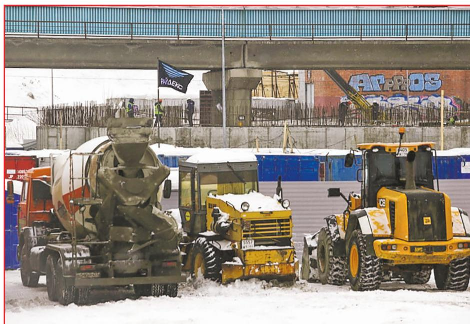
В некоторых местах из земли уже торчит арматура. А значит, внутри уже есть готовые сваи. Арматуру погружают в обсадную трубу, а уже потом начинают заливать бетон. Вместе они схватываются и становятся надёжной опорой для будущей арены.
