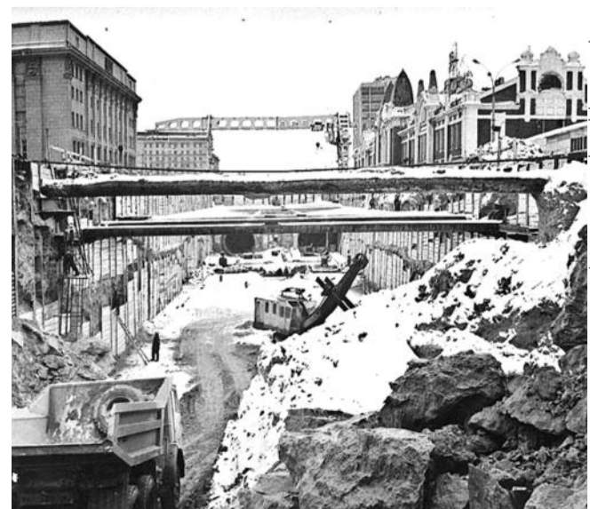
● НА ФОТО: СТРОИТЕЛЬСТВО СТАНЦИИ МЕТРО «ПЛОЩАДЬ ЛЕНИНА»
