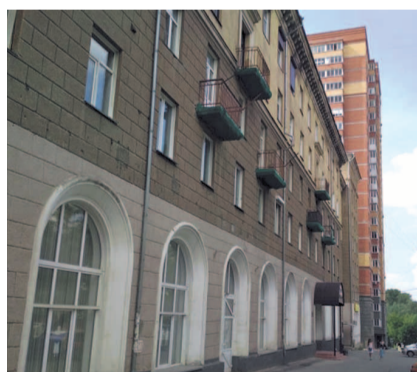
НА ФОТО: ОТРЕМОНТИРОВАННЫЙ ДОМ
