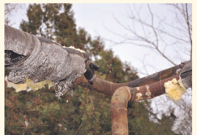
НА ФОТО: ЖИТЕЛИ ПЛАТЯТ ЗА ТЕПЛО В ДОМАХ, А НЕ НА УЛИЦЕ!
