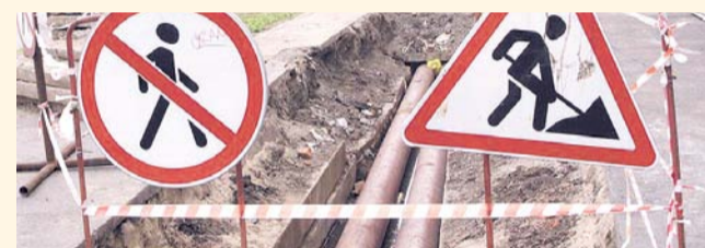
НА ФОТО: РЕМОНТ ТЕПЛОТРАСС ЗАВЕРШЕН
