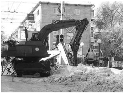
НА ФОТО: НА МОМЕНТ СДАЧИ НОМЕРА СПЕЦИАЛИСТЫ ГОРВОДОКАНАЛА ПРОДОЛЖАЛИ УСТРАНЯТЬ ПОСЛЕДСТВИЯ АВАРИИ
