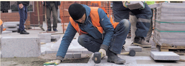
НА ФОТО: РЕМОТ БЛИЗИТСЯ К ЗАВЕРШЕНИЮ
