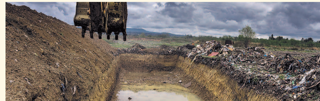
НА ФОТО: СТРОИТЕЛЬСТВО ПОЛИГОНА УЖЕ НАЧАЛОСЬ
