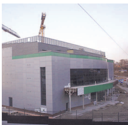
НА ФОТО: СТРОИТСЯ ВОЛЕЙБОЛЬНЫЙ ЦЕНТР
