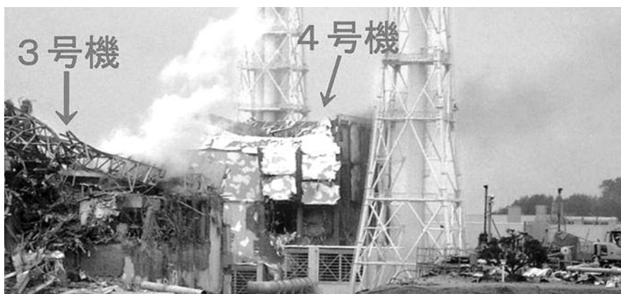
■ НА ФОТО: НА ИЗОБРАЖЕНИИ ВИДНЫ ПОВРЕЖДЕННЫЕ ТРЕТИЙ (СЛЕВА) И ЧЕТВЕРТЫЙ РЕАКТОРЫ АТОМНОЙ ЭЛЕКТРОСТАНЦИИ «ФУКУСИМА 1» В ФУКУСИМЕ К СЕВЕРУ ОТ ТОКИО
