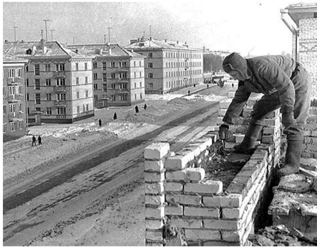
● НА ФОТО: ИДЕТ СТРОИТЕЛЬСТВО НА МОРСКОМ ПРОСПЕКТЕ
