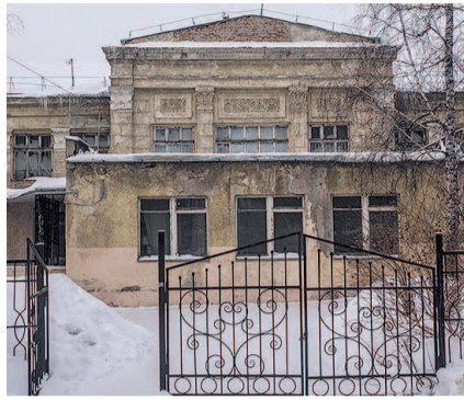
НА ФОТО: здание в плачевном состоянии
