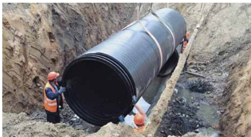
НА ФОТО: ЖИТЕЛИ БЬЮТ ТРЕВОГУ ИЗ-ЗА СТРОИТЕЛЬСТВА КОЛЛЕКТОРА
