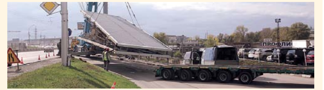
НА ФОТО: ДЕМОНТАЖ РЕКЛАМНОЙ КОНСТРУКЦИИ
