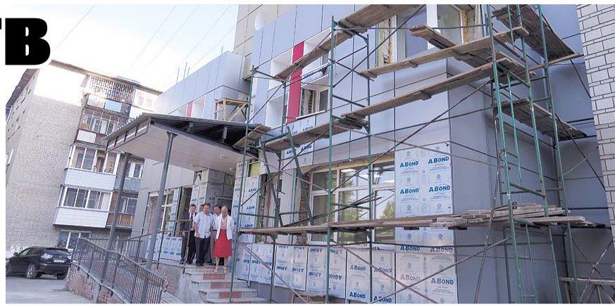
НА ФОТО: ИДЕТ РЕМОНТ ШКОЛЫ
