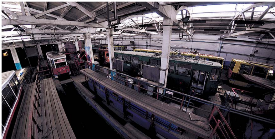
НА ФОТО: В ТРАМВАЙНОМ ДЕПО БУДУТ ИЗГОТОВЛИВАТЬ НОВЫЕ ТРАМВАИ
