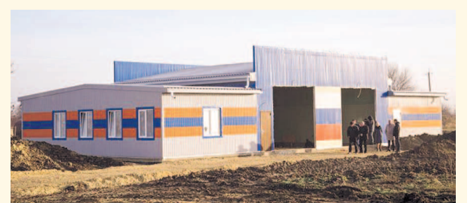
НА ФОТО: НОВОЕ ПОЖАРНОЕ ДЕПО
