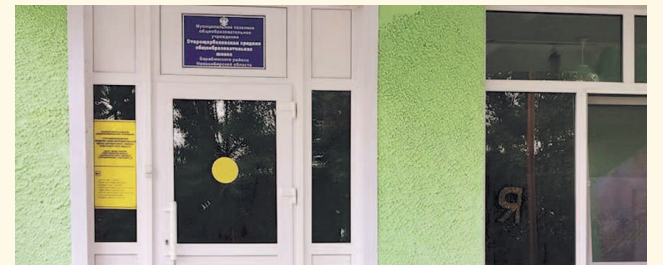
НА ФОТО: ПОМЕЩЕНИЕ ДЛЯ ДОШКОЛЬНИКОВ ОТРЕМОНТИРОВАНО
