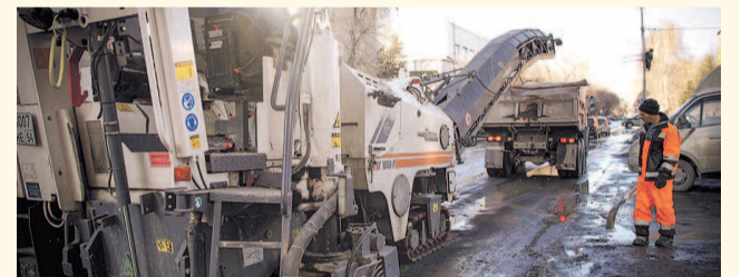
НА ФОТО: ТЕКУЩИЙ РЕМОНТ ДОРОГ НАЧАЛИ В НОВОСИБИРСКЕ
