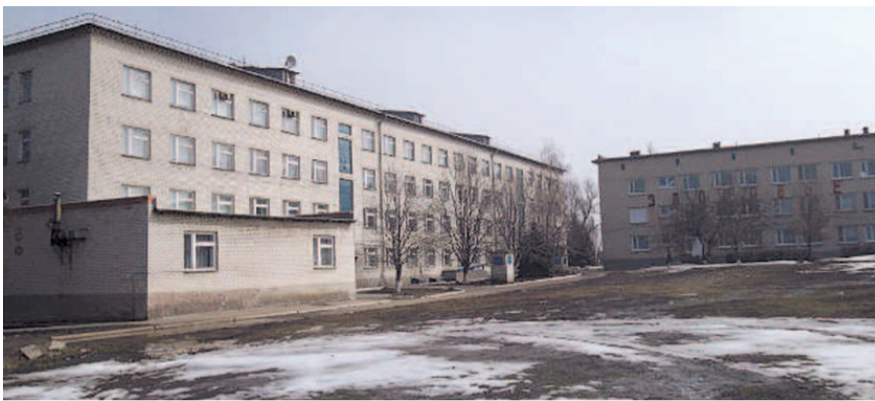
НА ФОТО: БОЛЬНИЦЕ В КУЙБЫШЕВЕ ТРЕБУЮТСЯ КАДРЫ И ОБОРУДОВАНИЕ
