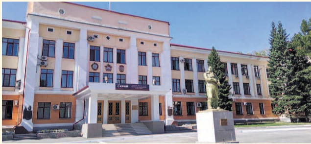
НА ФОТО: ЗАВОД БУДЕТ ОБНОВЛЕН
