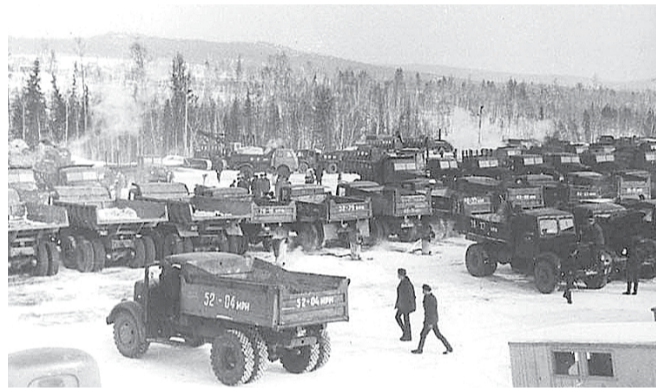
НА ФОТО: СТРОИТЕЛЬСТВО УСТЬ-ИЛИМСКА
