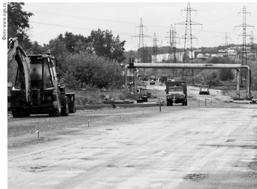
НА ФОТО: НА УЛИЦЕ ОБЪЕДИНЕНИЯ ИДУТ ДОРОЖНЫЕ РАБОТЫ
