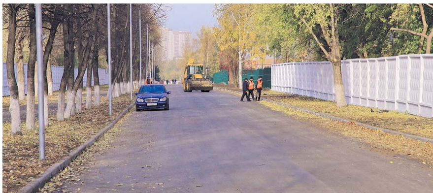
НА ФОТО: КОМПЛЕКСНЫЙ РЕМОНТ ДОРОГ В 2017 ГОДУ ЗАВЕРШЕН
