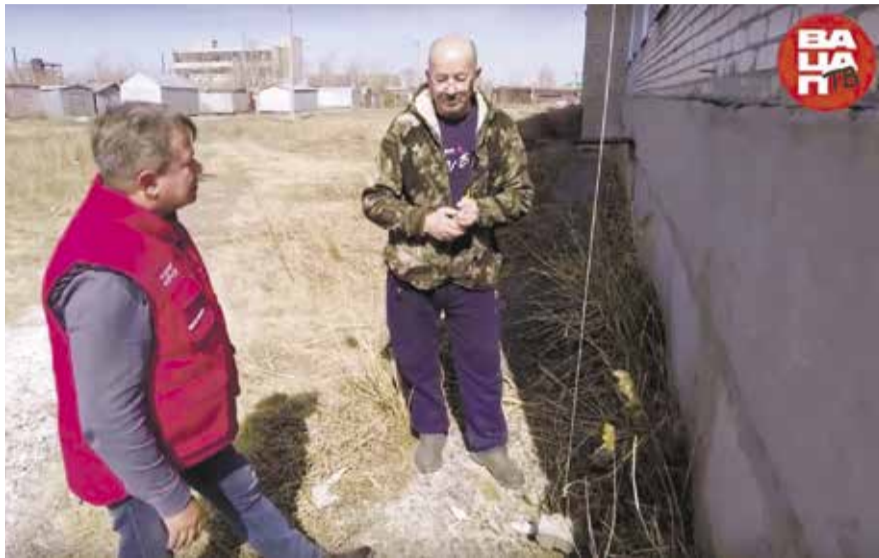
НА ФОТО: АНДРЕЙ ЖИРНОВ ИЗМЕРЯЕТ УГОЛ НАКЛОНА ПАДАЮЩЕГО ДОМА В ТАТАРСКЕ
