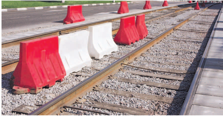
НА ФОТО: ПОДГОТОВКА ТРАМВАЙНЫХ ПУТЕЙ — ВАЖНАЯ ЗАДАЧА
