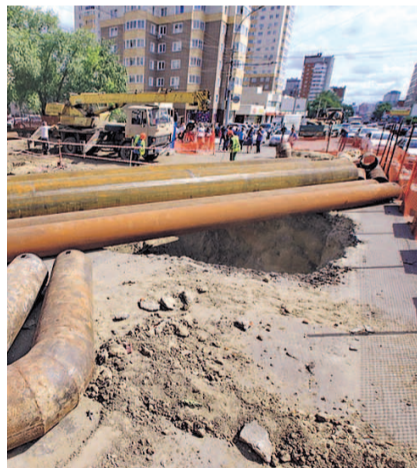
НА ФОТО: РЕМОНТ ТЕПЛОТРАСС И ДОРОГ СИНХРОНИЗИРОВАЛИ
