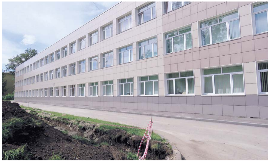
НА ФОТО: НОВОЕ ЗДАНИЕ ШКОЛЫ
