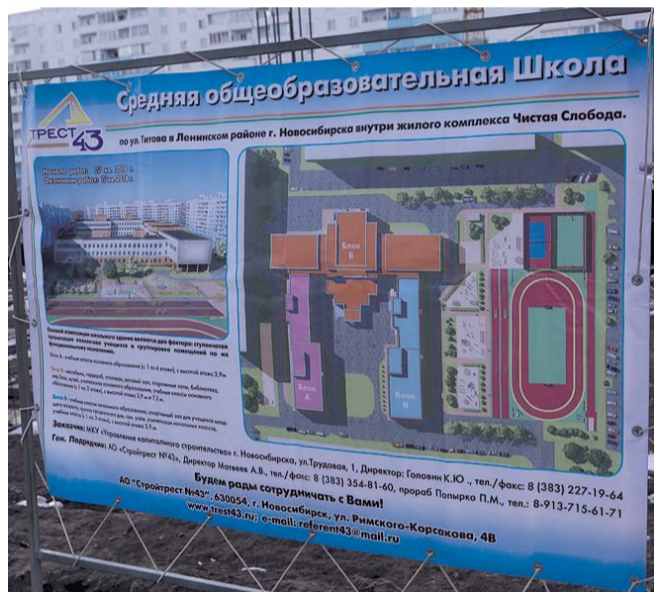
НА ФОТО: ИДЕТ СТРОИТЕЛЬСТВО
