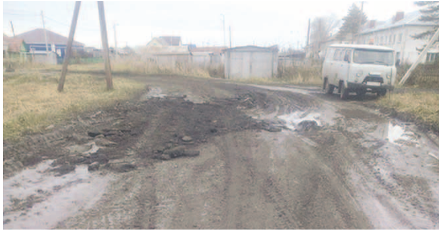
НА ФОТО: С. НЕКРАСОВКА ЧАНОВСКОГО РАЙОНА, ГДЕ ЯКОБИ СДЕЛАЛИ РЕМОНТ ДОРОГИ
