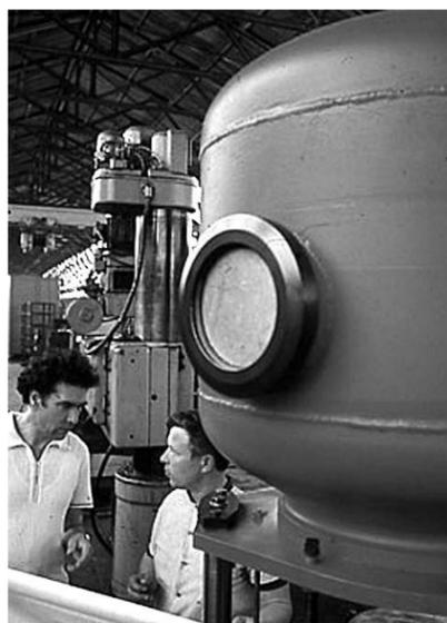
НА ФОТО: УСТАНОВКА ДЛЯ СВАРКИ ВЗРЫВОМ
