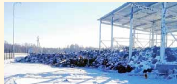
НА ФОТО: СВАЛКА «ЭКОЛОГИИ-НОВОСИБИРСК» В ВЕНГЕРОВСКОМ РАЙОНЕ
