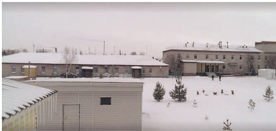
НА ФОТО: здания инфекционной больницы в КОЧЕНЕВО
