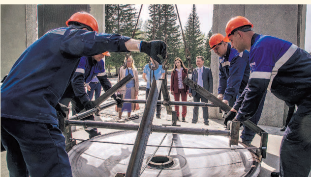
НА ФОТО: УСТАНОВКА ОТРЕСТАВРИРОВАННОЙ ЧАШИ
