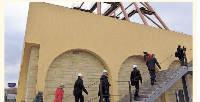
НА ФОТО: СТРОИТЕЛЬСТВО НОВОГО КОЛЕСА ОБОЗРЕНИЯ
